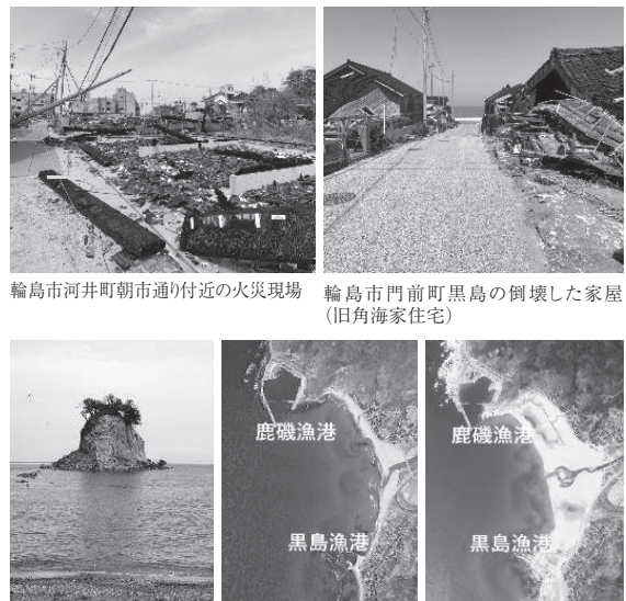
輪島市河井町朝市通り付近の火災現場 輪島市門前町黒島の倒壊した家屋(旧角海家住宅) 珠洲市宝立町の崩壊した見附島 隆起による輪島市門前地区の海岸線の変化(2010年5月→2024年4月)(国土地理院撮影の空中写真に当所加筆)
