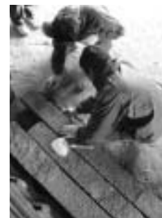
作業風景(土間づくり)
