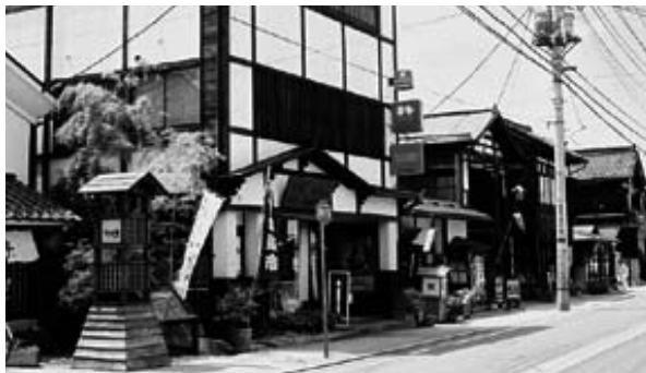
写真4 空き店舗だった木造造りの商家群を大正浪漫調に改修し、記念館や飲食店にリニューアル
